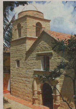
La capilla fue construida en 1778 y forma parte de la sede de la alcaldía municipal.
