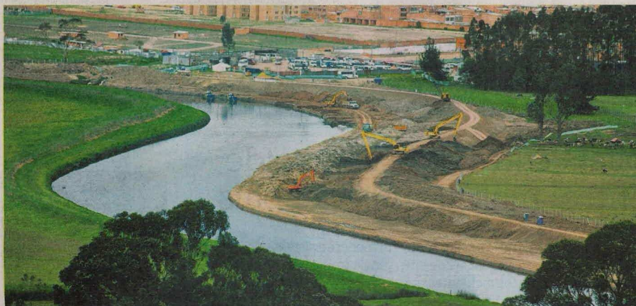
De 30 a 60 metros pasó el cauce del río Bogotá, en 68 kilómetros de su recorrido. Se crearon siete zonas de inundación controlada. FOTO: CIA DE CUNDINAMARCA
